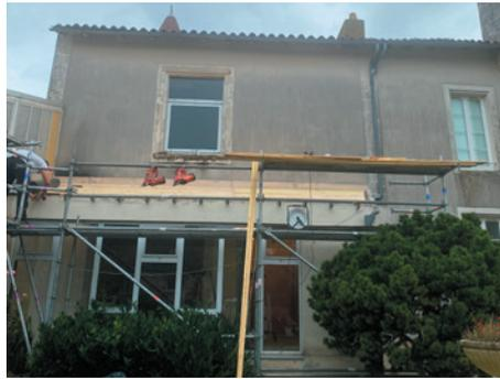
D'importants travaux ont débuté dans la salle Château Vieux, avec l'enlèvement de la verrière devenue vétuste et la réfection d'une partie de la toiture, réalisés par l'entreprise CZ Couverture Zinguerie de St Hilaire de Villefranche.
